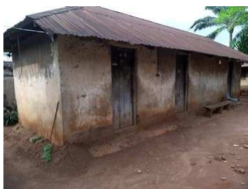
Aguata PHC, het oude toiletgebouw
