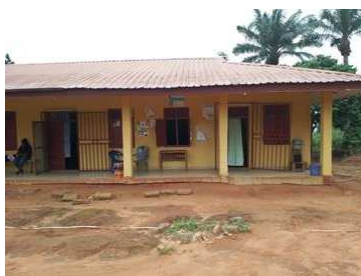
Een gebouw bij het Ukwulu PHC!
